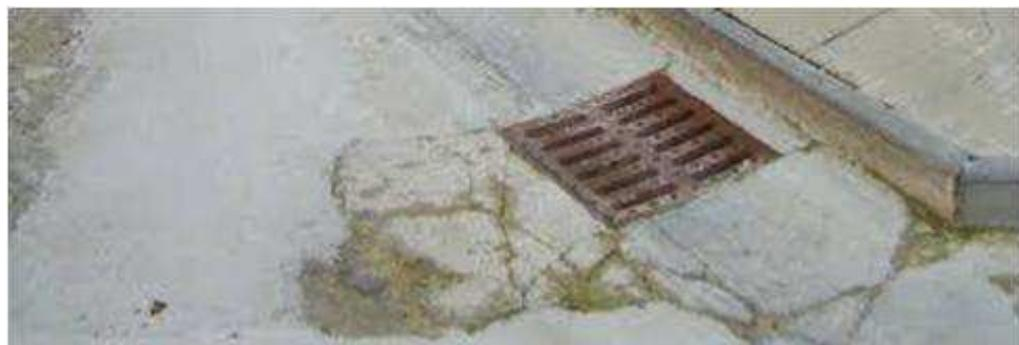
Può accadere che la falda freatica in risalita si trovi per tutto il tempo dell'alluvione ad un livello superiore al piano della fognatura. Qualsiasi apertura nella tubazione della fogna a contatto con la falda, (foro i cedimento), provocherà un rigurgito di acqua di falda nel sistema fognario. Questo lo si nota all'impianto di trattamento perché aumenta il volume dei liquami da trattare. I problemi provocati da queste infiltrazioni son principalmente di due tipi:
