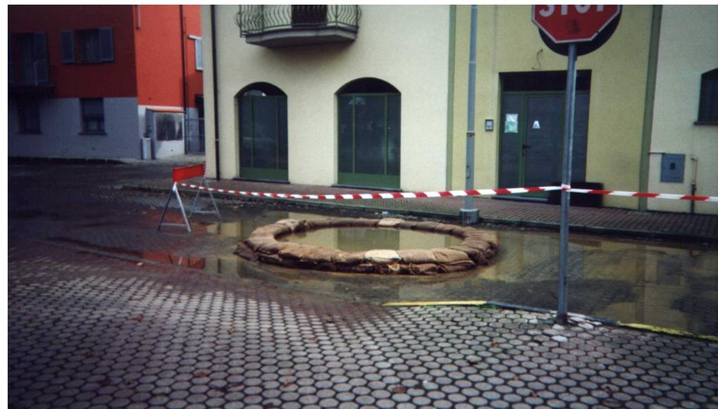
Centro del paese, l'innalzamento della falda freatica e il movimento delle sabbie sottostanti alla piazza hanno generato una risorgiva. E' stata arginata per evitare che l'estrazione di sabbia provocasse un buco sotto la pavimentazione della piazza.
